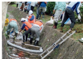
水路で実際に土のう積み体験する訓練(滋賀県)
