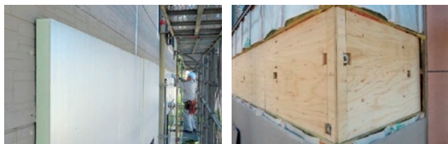
既存の外壁に上張り施工する「ソトダンプラス」
