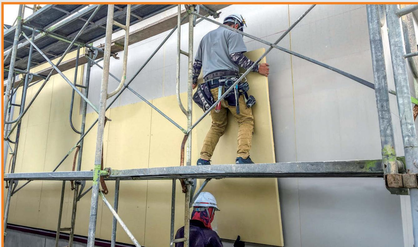
QDパネル鉄骨外張り断熱システムの施工状況
