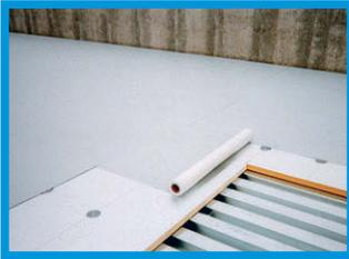
鉄骨造の陸屋根における硬質ウレタンフォーム断熱材の施工状況
